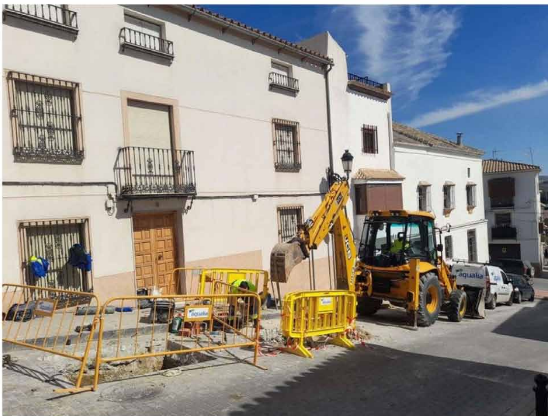
Obras de mejora de rendimiento de Aqualia en Baena
